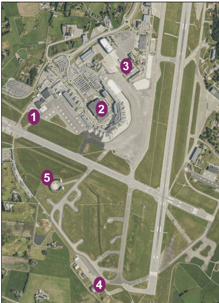
Figur 26. Vurderte lokasjoner for etablering av droneinfrastruktur på Stavanger lufthavn (Kilde: Avinor).
